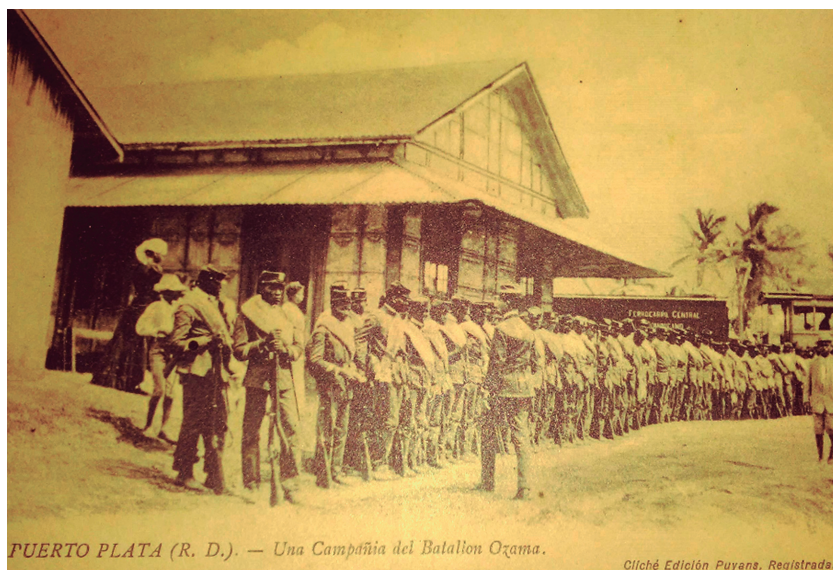
Compañía del Batallón Ozama en la Estación del Ferrocarril Central de Puerto Plata.
